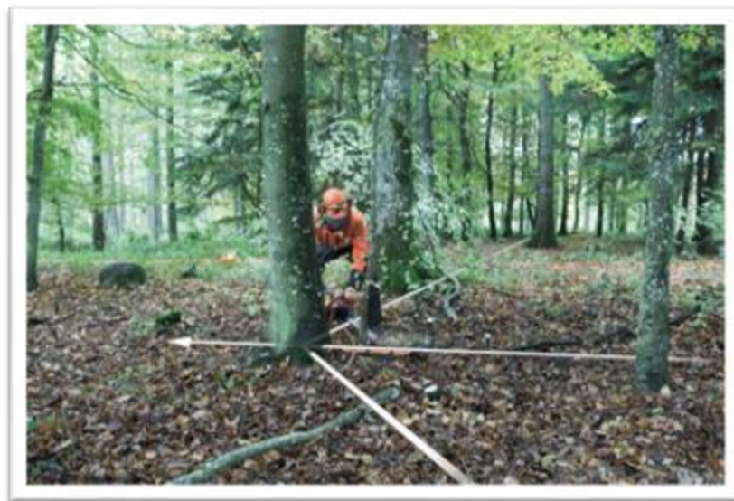
28.att. Atkāpšanās ceļu izveidošana
